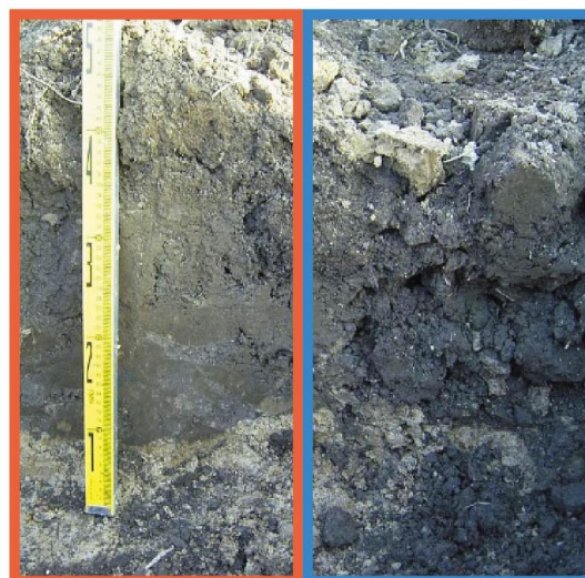
心土破碎施工前
