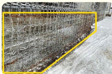
写真 左) 防鳥扉の設置事例、右) キツネ侵入防止のためネットを強化した事例
